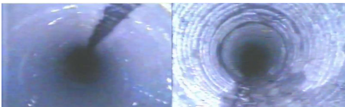
(c) 钻孔岩层段孔壁探查情况
