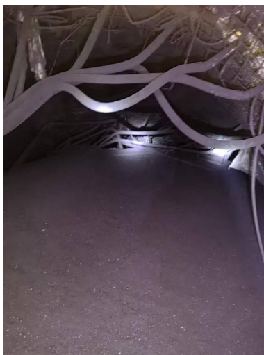
（a）现场实拍煤渣堆积形态
