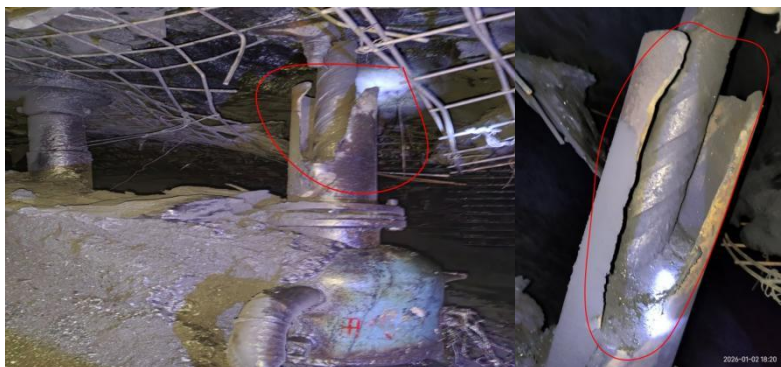
图 3 孔口防喷装置形态和损坏情况
